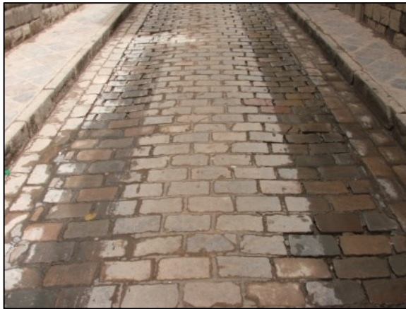
Calzada vehicular adoquinado con piedra natural
