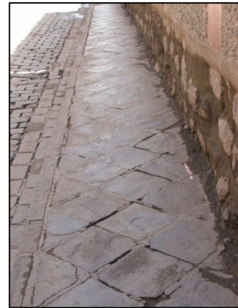
Veredas de loseta de piedra, de aproximadamente de 0.30X0.30cm con una inclinación de 45°, confinadas con sardinel de piedra.
