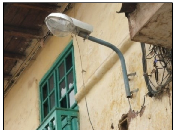
Luminarias sostenidas mediante pastorales metálicos, los que están sujetos a la pared.
