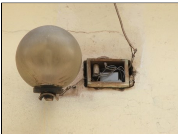
Luminarias de servicio de alumbrado público; consiste en esferas adosadas a los muros.
