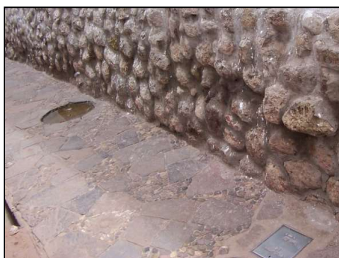
CONSTITUIDO POR LAJAS DE PIEDRA IRREGULA Y EMPEDRADO
