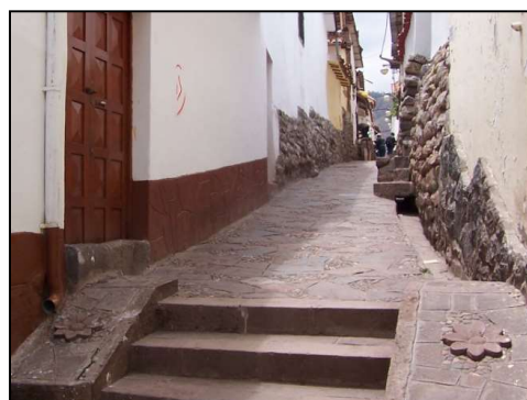
CONSTITUIDO POR LAJAS DE PIEDRA IRREGULA Y EMPEDRADO
