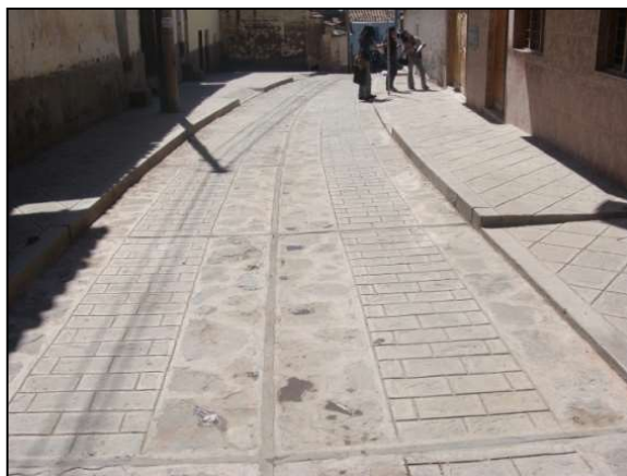
CALZADA CON ACABADO DE PIEDRA IRREGULAR CON HUELLAS DE ADOQUINES DE PIEDRA
